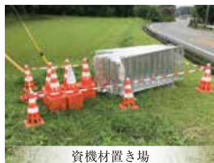
資機材置き場
